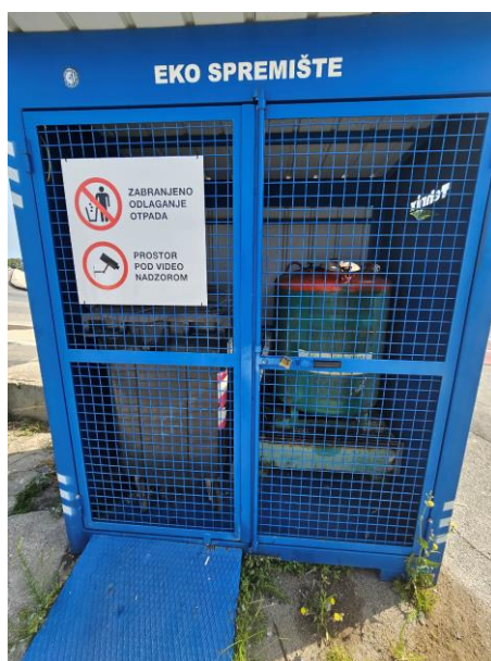
Slika 59 Eko spremište sa spremnikom za prihvat otpadnih ulja te rabljenih uljnih filtera s plovila
